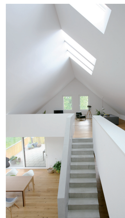
Sichtbetontreppe führt ins Dachgeschoss.
